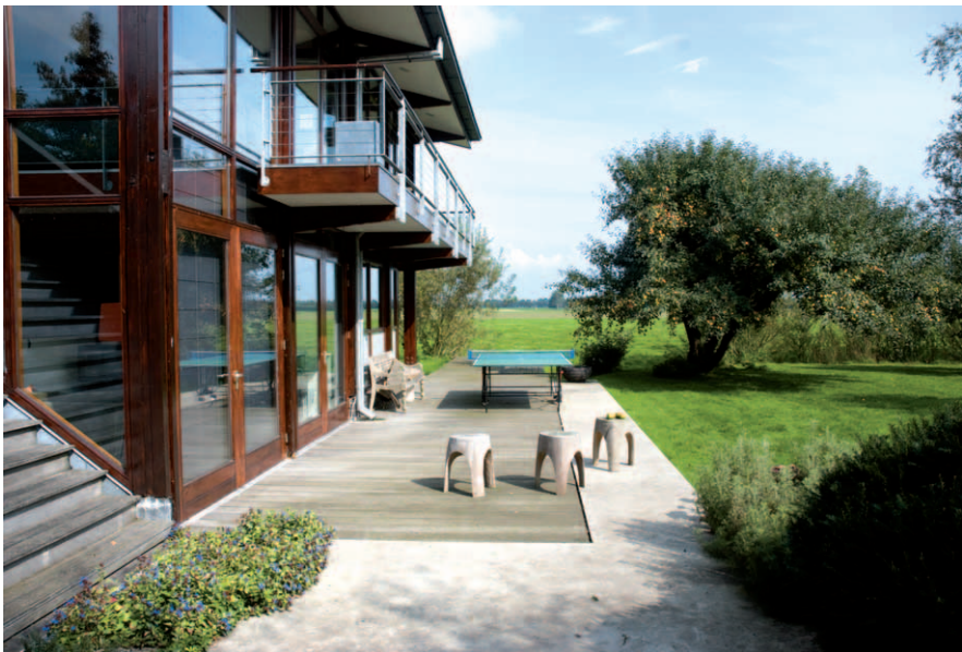
Een strip van beton en hout verankert het woonhuis aan de beide zijanten van het perceel.
